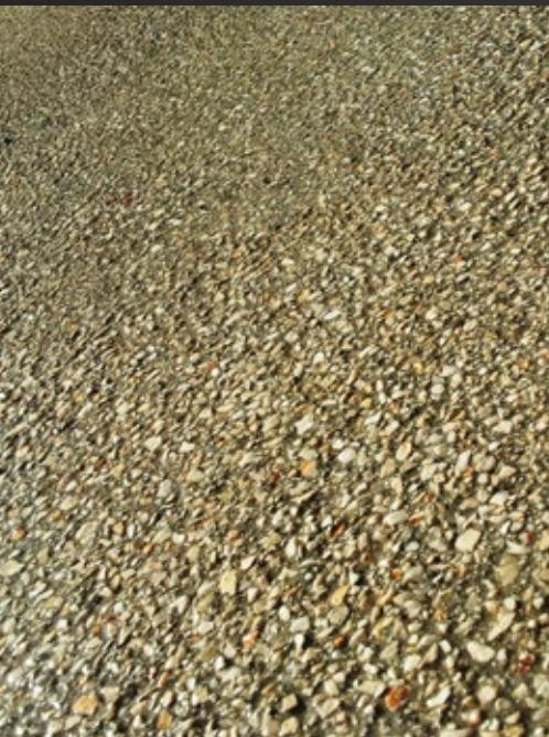
**CoolirBASIC** se izvodi razastiranjem i ravnanjem betona posebno razvijene recepture. Beton se, nakon površinske obrade, prska posebnim sredstvom koje omogućuje da se nakon završenog vezanja betona ukloni površinski sloj cementne paste. Na taj način zrna kamenog agregata postaju vidljiva i jasno određuju teksturu i strukturu površine betona.
