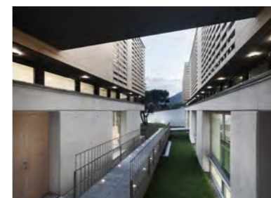
PREMIO ESPECIAL Edificación Sostenible. Oak House School Barcelona, España
