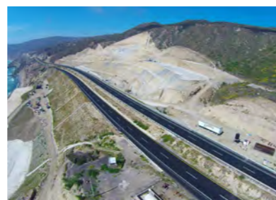
Infraestructura. Restitución del Terraplén de la Carretera Tijuana-Ensenada al KM 93 Ensenada, México
